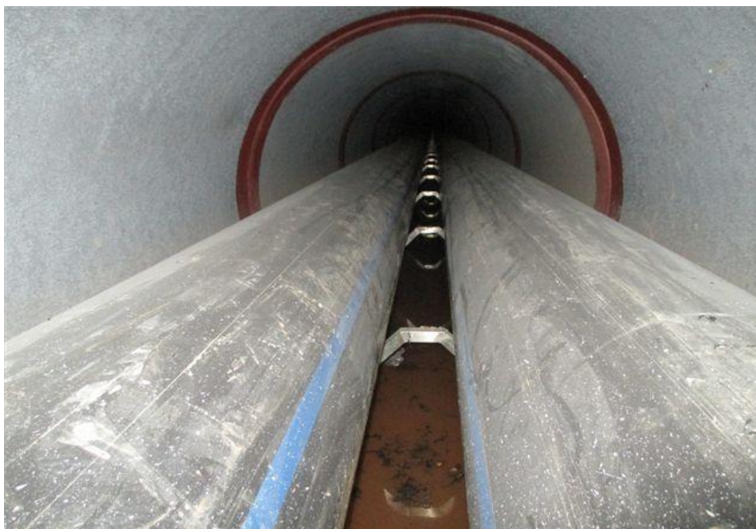
Slika 2.8. Dovodne cijevi u tunelu
