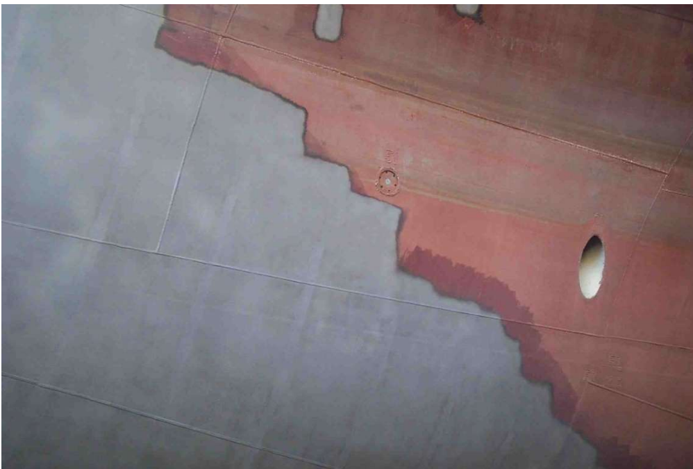
Slika 2-10. Opjeskarena površina spremna za bojenje. Izvor: autor
