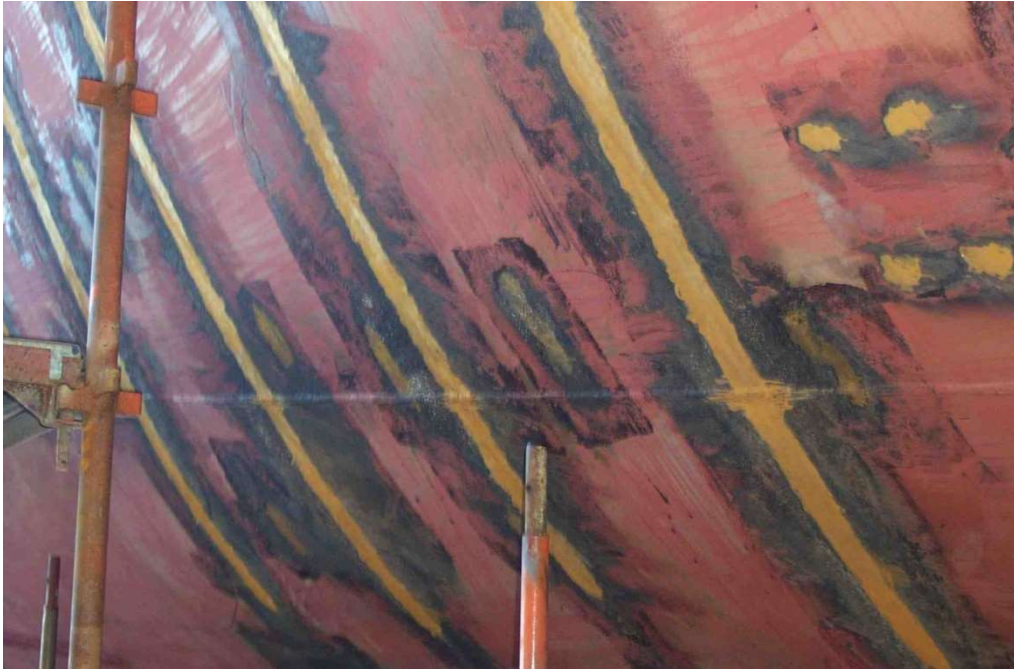
Slika 2-8. Izgled površine nakon rezanja potporne strukture i brušenja površine. Izvor: autor
