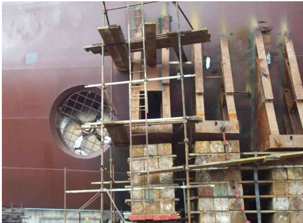
Slika 2-7. Izgled potporne strukture broda na navozu, prikaz 2. Izvor: autor
