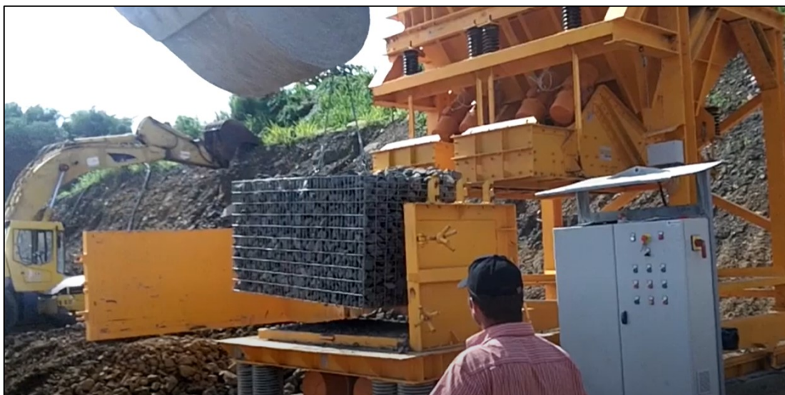
Slika 7.19. Podizanje i transport gotovog gabiona iz kalupa vibratora
