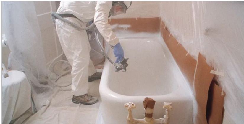
Slika 6.21. Restauracija kade od lijevanog željeza emajliranjem [85]
