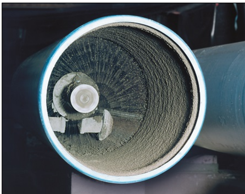
Slika 6.20. Postavljanje betonske prevlake na unutarnju stranu cjevovoda [83]
