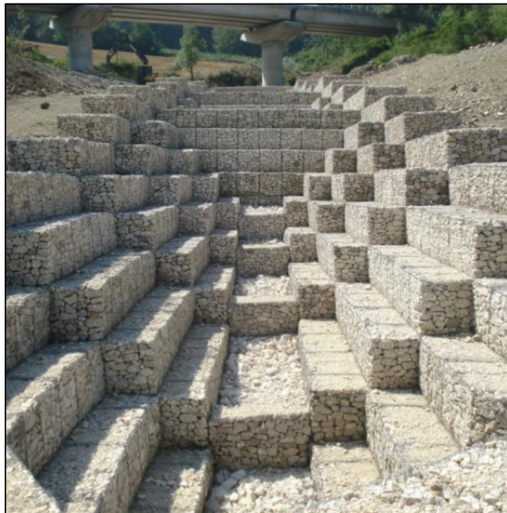
Slika 7.4. Odvodni kanali stabilizirani pomoću gabiona [94]
