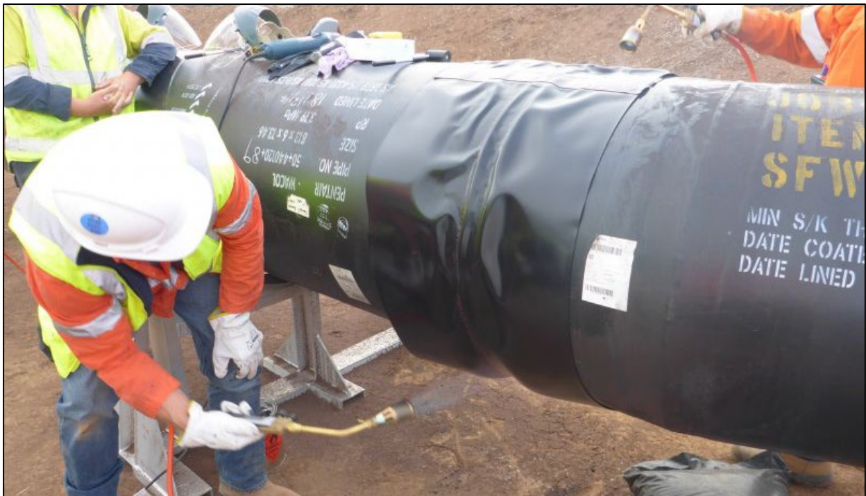
Slika 6.24. Bitumenizacija zavarenog spoja plinovoda [90]
