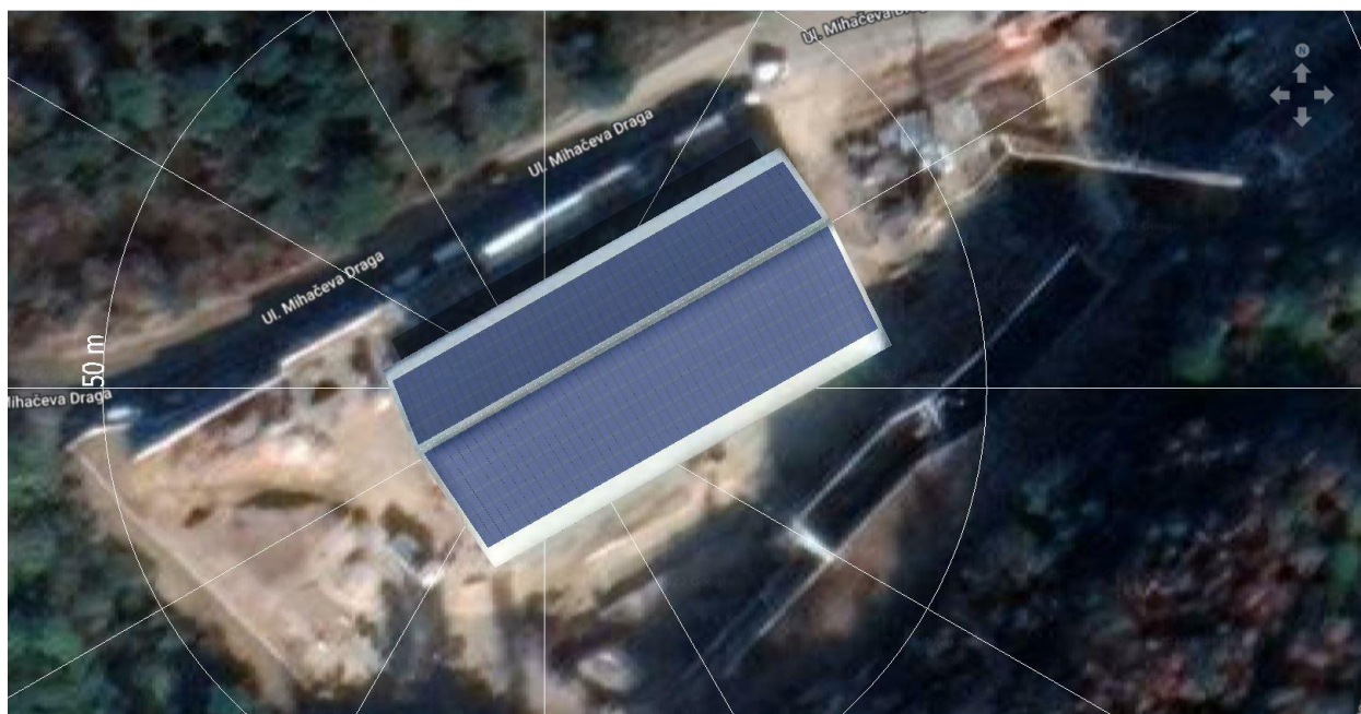
Slika 5. 1. Prikaz građevine hale sortirnice s fotonaponskim panelima
