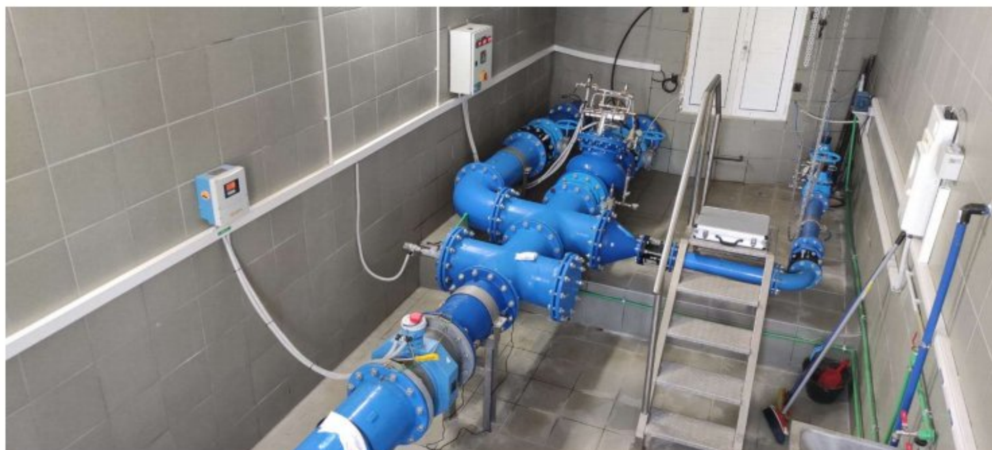
Slika 9: Unutrašnjost prekidne komore Luterija
