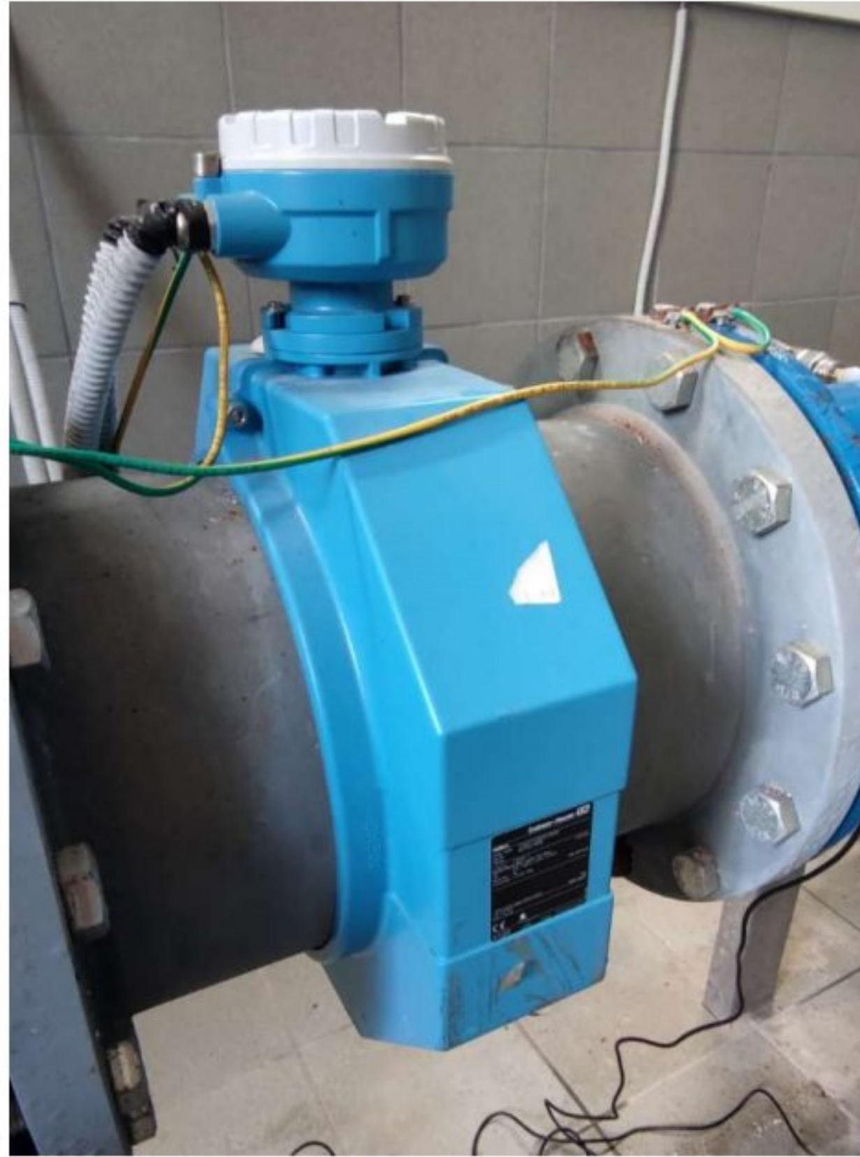
Slika 1: Elektromagnetski mjerač protoka Endress+Hauser
