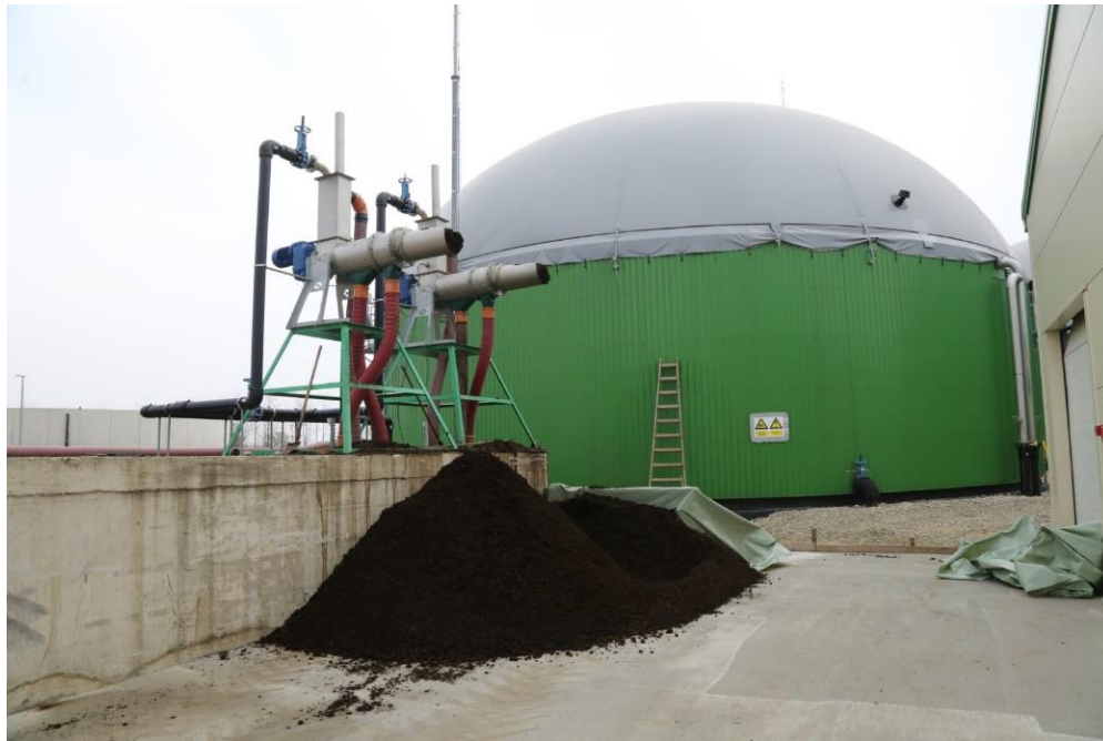
Slika 6.11 Vertikalni digestor s membranskim spremnikom bioplina [32]
