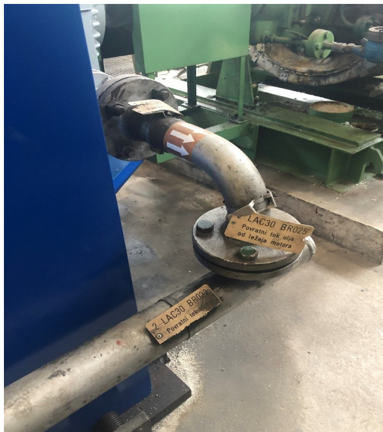
Slika 5.6. Prirubnica povratnog toka ulja kliznog ležaja
