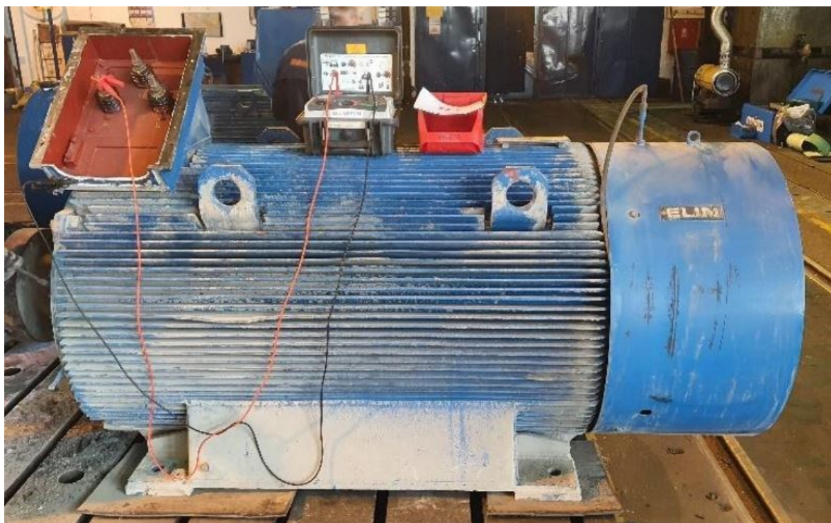
Slika 7.5. Mjerenje otpora izolacije namota statora
