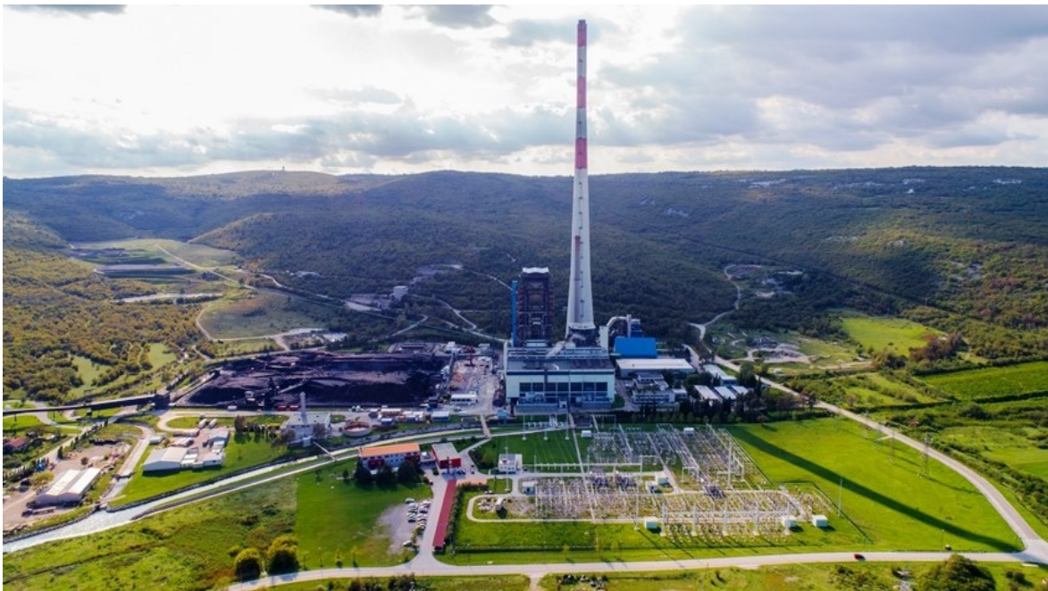
Slika 2.1. Postrojenje termoelektrane Plomin
