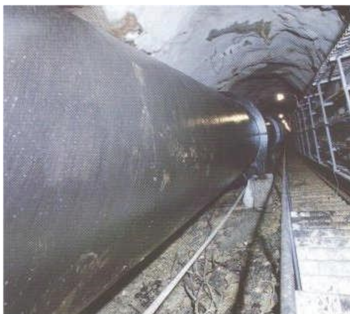
Slika 3.4. Tlačni cjevovod HE Rijeka
