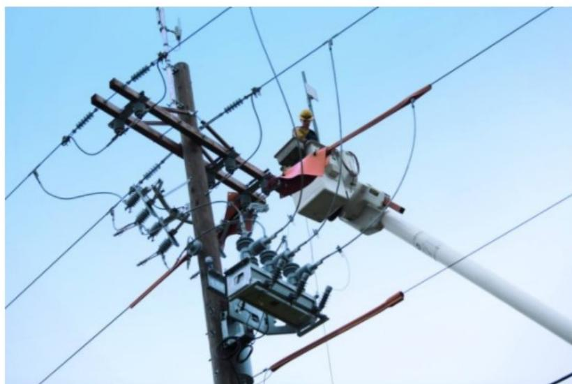
*Slika 5.6. Vakuumski prekidač proizvođača SIEMENS postavljen na stupu distribucijske mreže*
