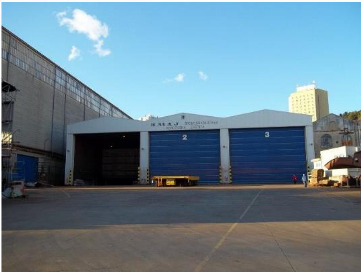
Slika 7.11. Hala za korozivnu zaštitu [6]
