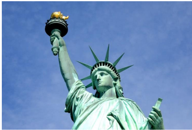
Slika 3.2. Ravnomjerna opća korozija na spomeniku Kip slobode [22]
