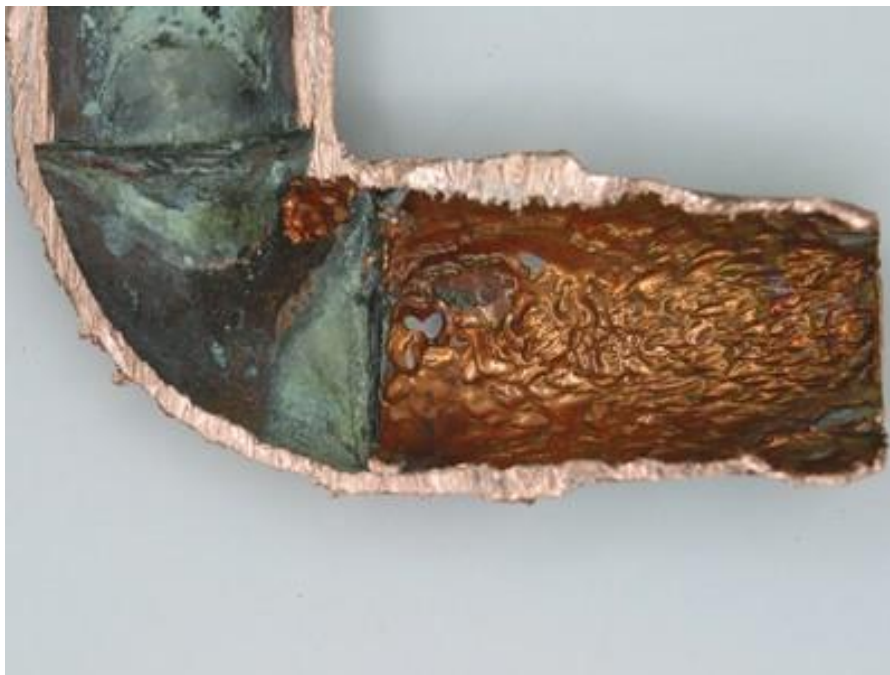
Slika 3.20. Erozijska korozija unutrašnjosti bakrene cijevi [41]
