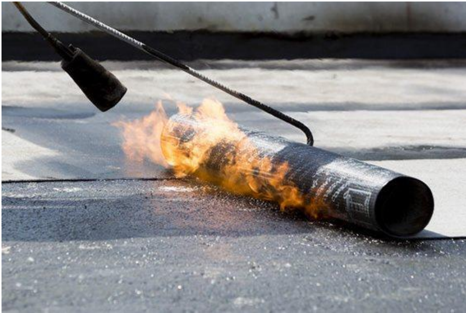
Slika 4.6. Bitumenizacija ravnog krova [47]
