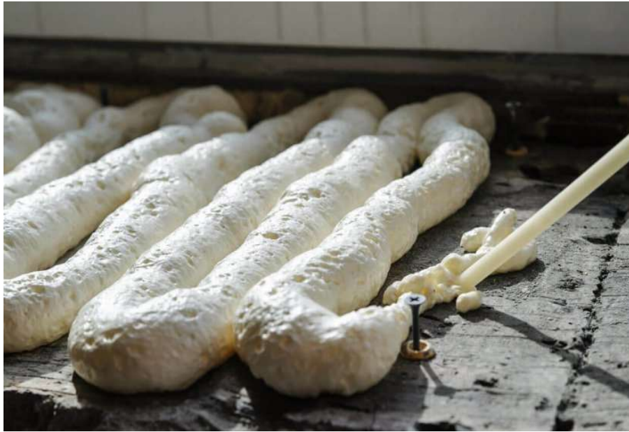
Slika 3.14 Špricanje izolacijske pjene
