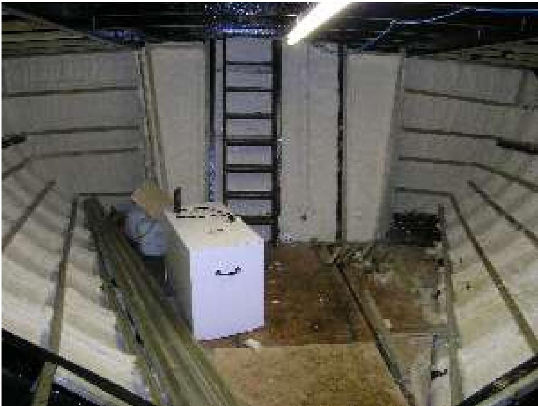
Slika 3.12 Postavljene drvene gređice, [5]
