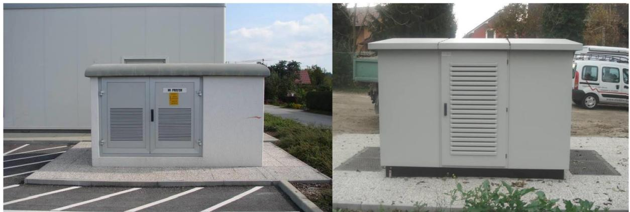
*Slika 4.6. Prikaz jednostavne TS kabelske izvedbe (JKTS): betonska (lijevo) i limena (desno).*
