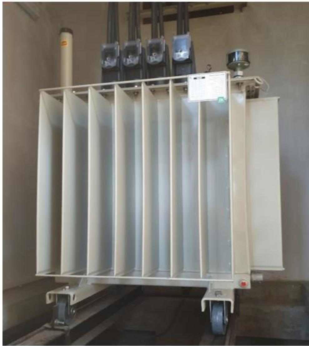
*Slika 5.8. Nova izvedba transformatora snage 400 kVA.*
