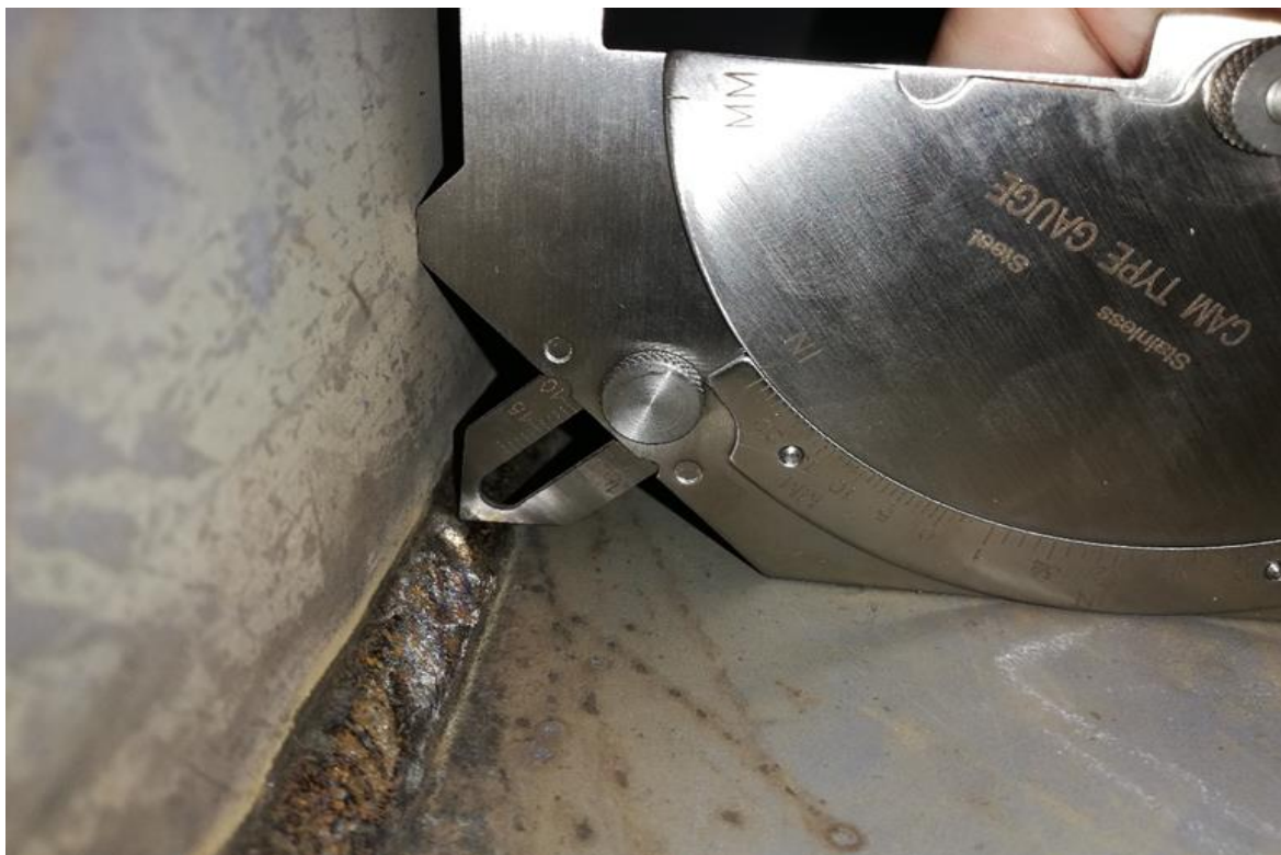
Slika 4.9 Prikaz kontrolnog kuta zavarenog spoja alatom MG-11. Priložen dokument kojim se potvrđuje korištenje izvornih slika brodogradilišta 3. Maj
