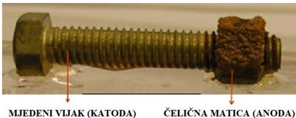
Slika 5.28. Galvanska korozija čelične matice na mjedenom vijku [12]
