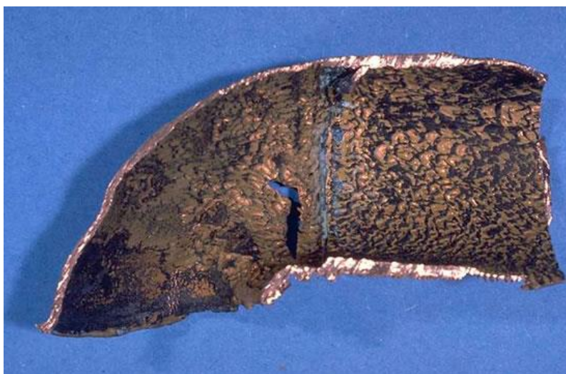
Slika 5.19. Erozijska korozija bakrene cijevi [40]
