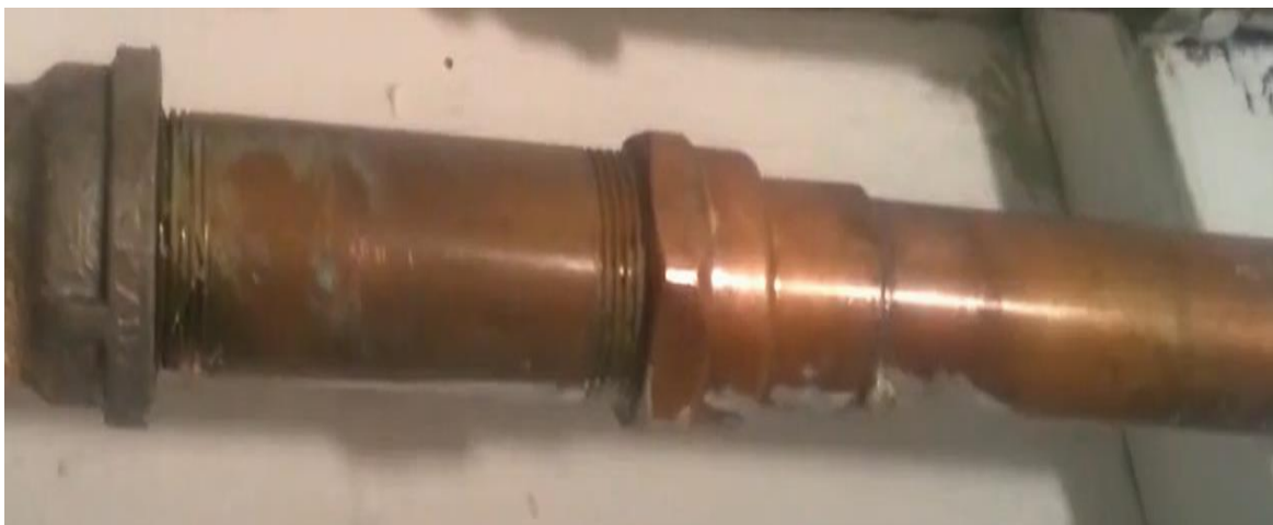
Slika 5.30. Pravilno spojene cijevi od različitih materijala [53]
