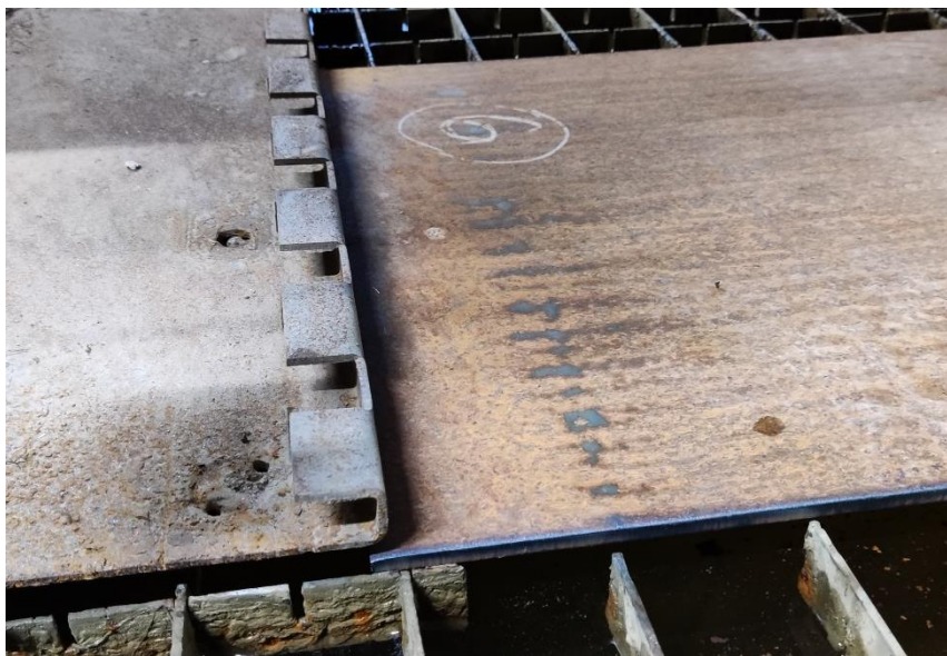
Slika 7.26. Postavljanje ploče do graničnika
