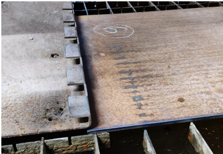
Slika 7.26. Postavljanje ploče do graničnika
