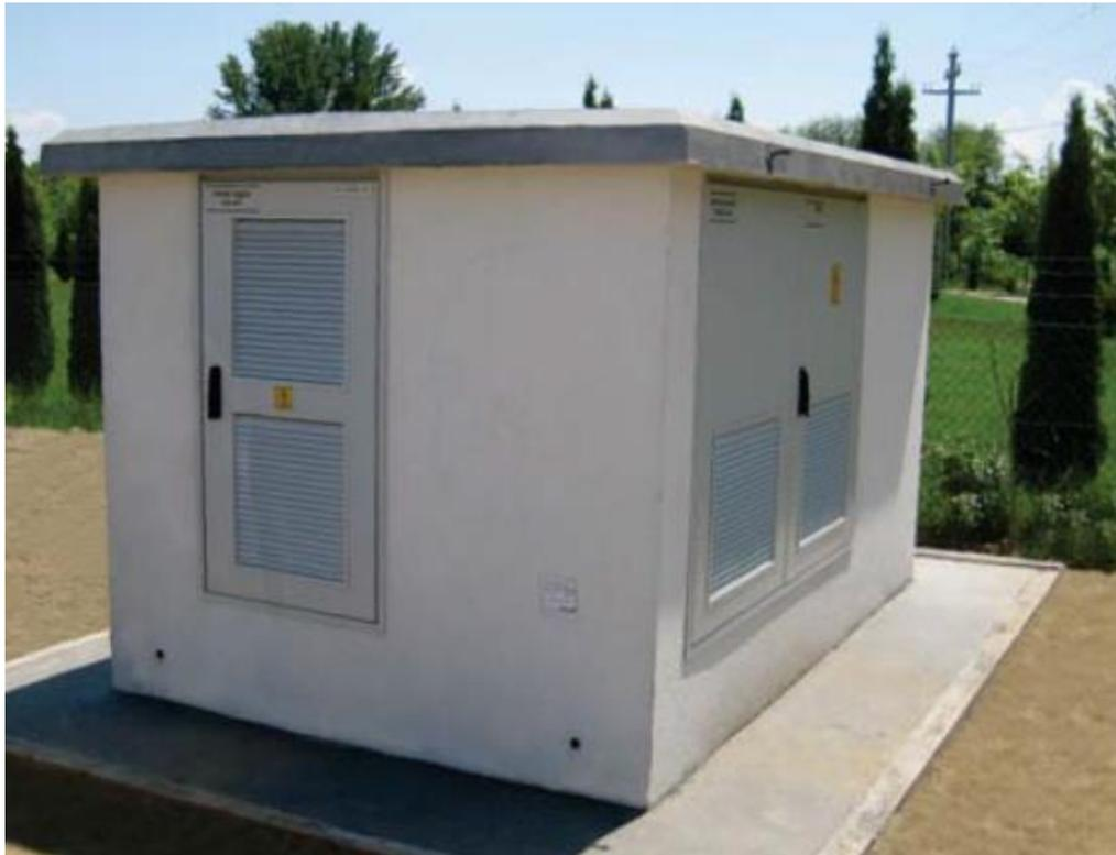
Slika 5.6 Primjer TS 20(10)/0.4 kV, 630 kVA [21]
