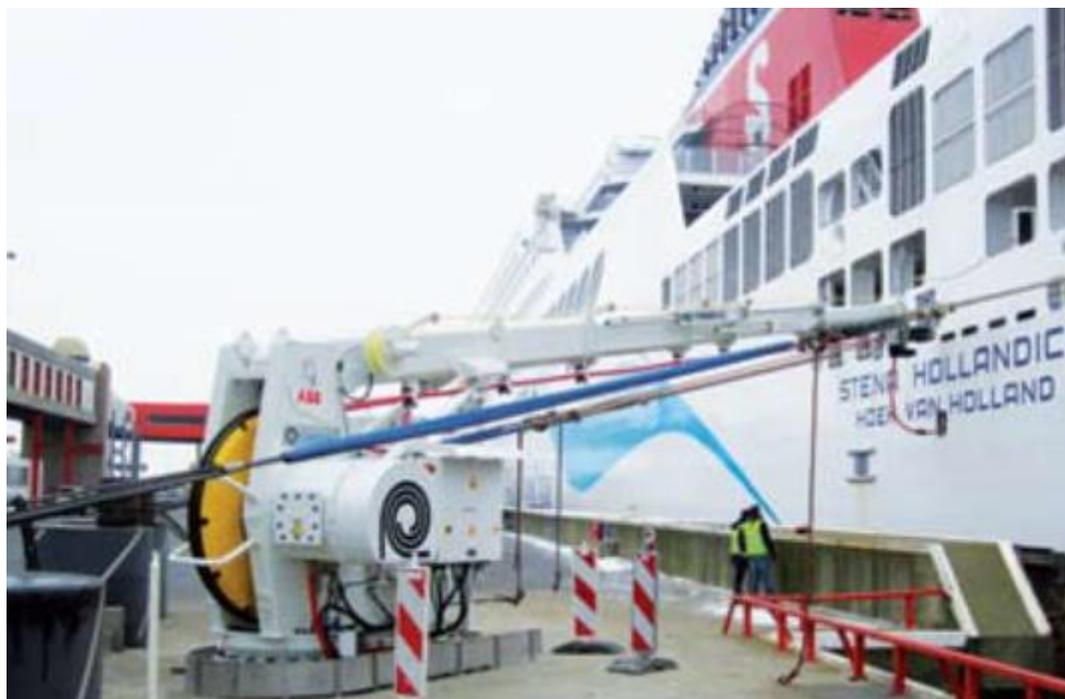
*Slika 4.2 Priključenje broda Stena Hollandica na kopneni priključak [15]*
