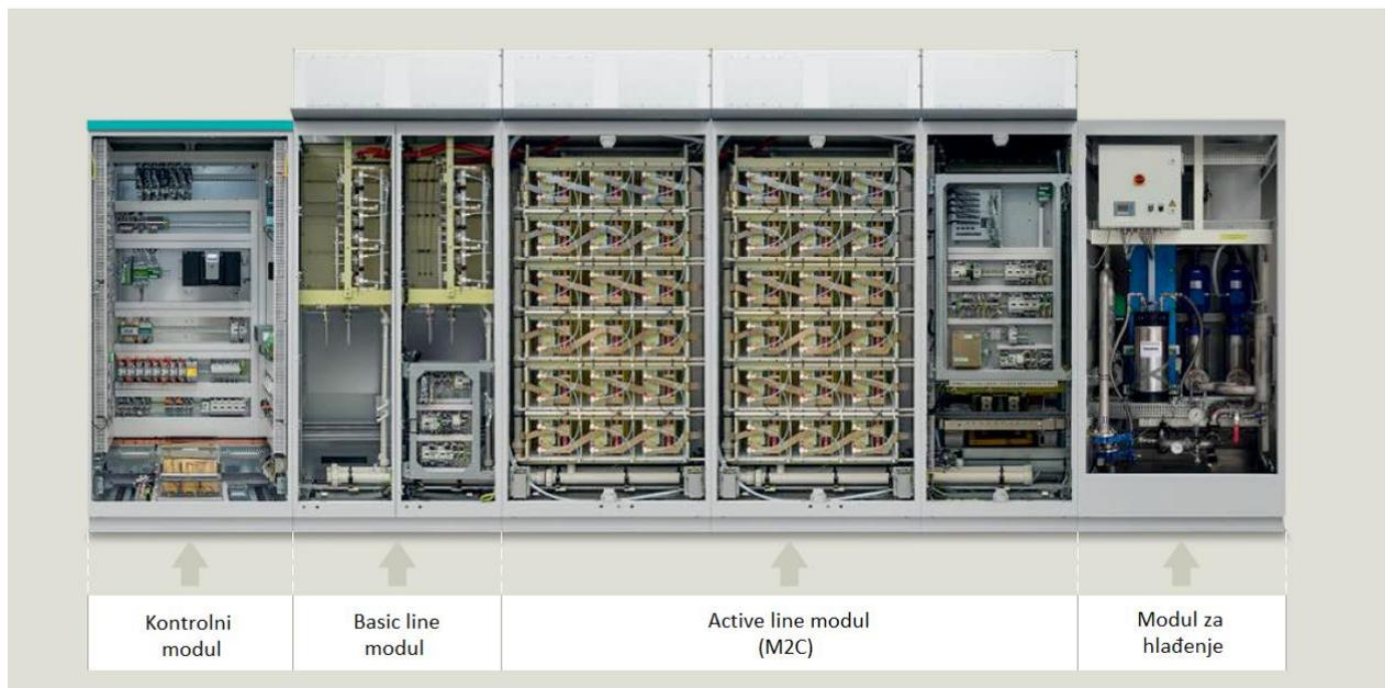
*Slika 4.7 Prikaz SINAMICS SM120 kabineta sa modulima [18]*
