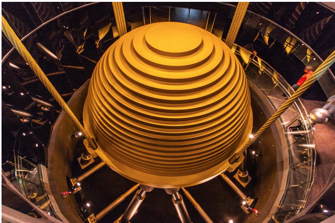
Slika 2.1. Prigušivač prilagođene mase u neboderu Taipei 101, s utegom kuglastog oblika teškim 660 tona [2]
