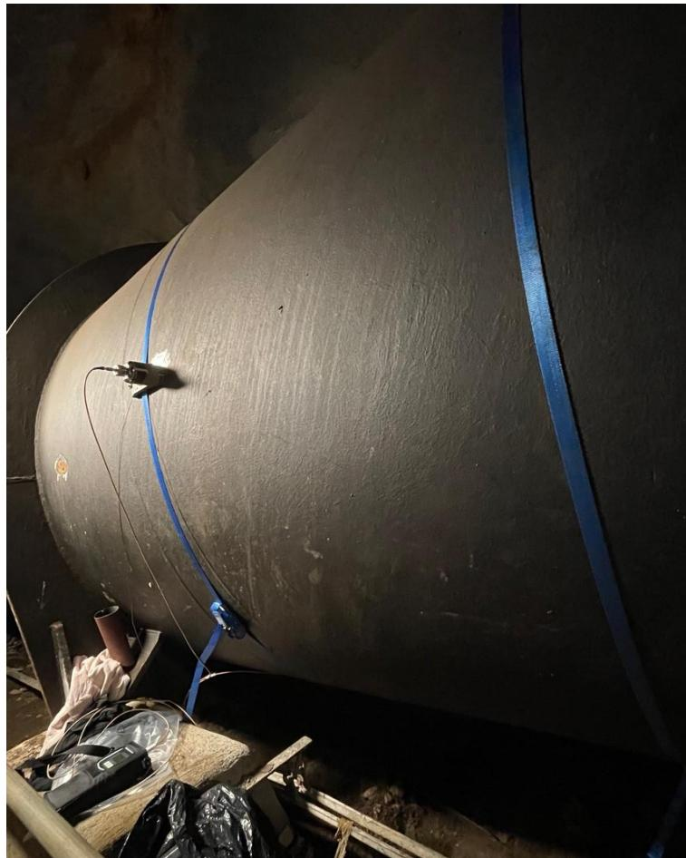
Slika 4.11. Montirani senzori ultrazvučnog mjerača na tlačnom cjevovodu HE Rijeka
