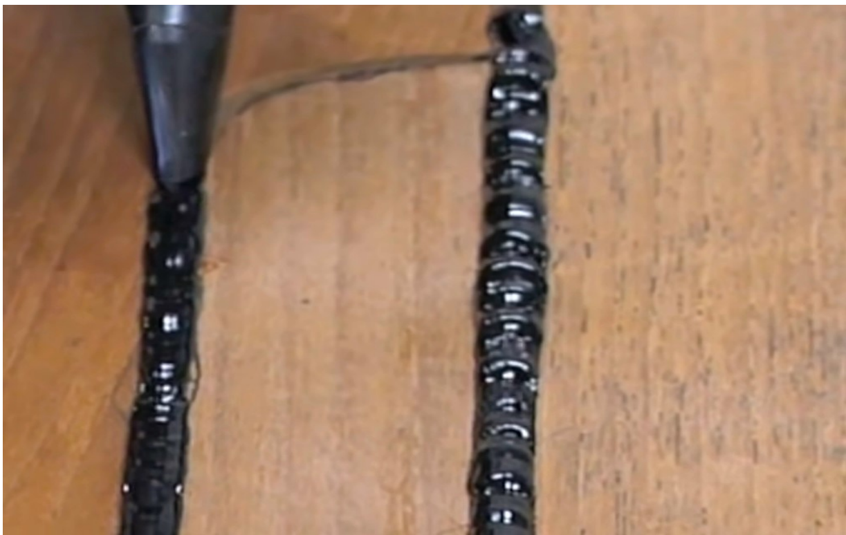
Slika 2.10. Brtvljenje trenica palube [11]
