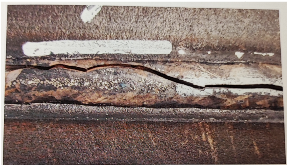
Slika 3.1. Uzdužna pukotina u sučeljenom zavarenom spoju [5]
