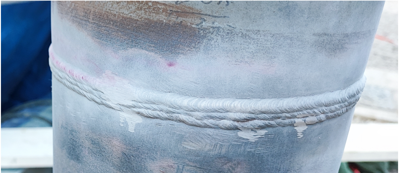
Slika 5.5. Razvijač nakon isteka vremena razvijanja sa prednje strane zavara
