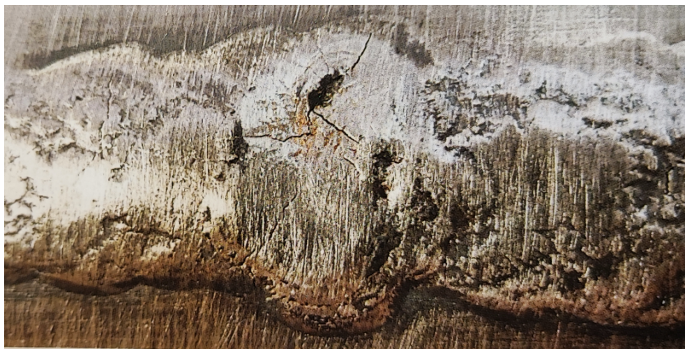
Slika 3.3. Zvjezdasta pukotina u zavaru [5]
