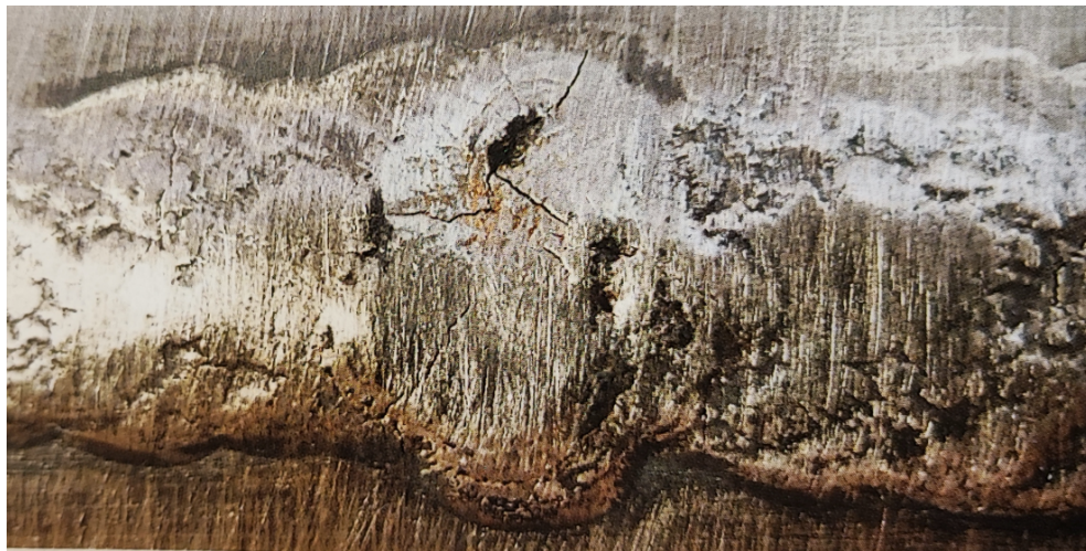
Slika 3.3. Zvjezdasta pukotina u zavaru [5]
