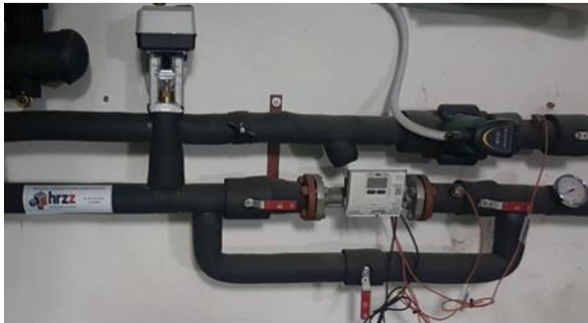
Slika 5.4 Regulacijska armatura ulazne temperature fluida prijenosnika topline u latentni spremnik topline
