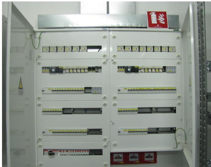
Slika 3.10. ABB industrijski razdjelni ormar [7]
