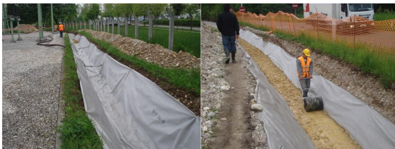
Slika 4.6. Polaganje geotekstila i priprema kablenske posteljice [1]
