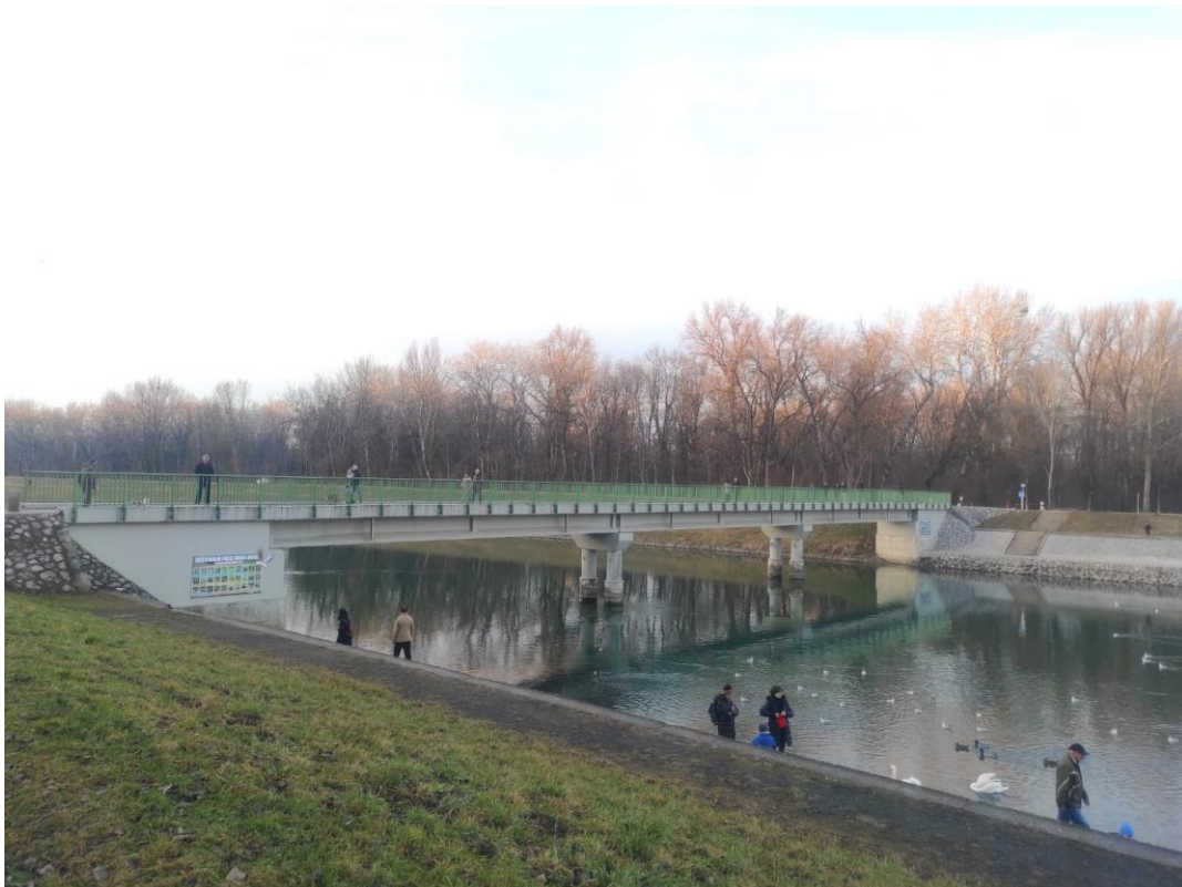
Slika 4.2: Most na kojem je obavljeno mjerenje radarom
