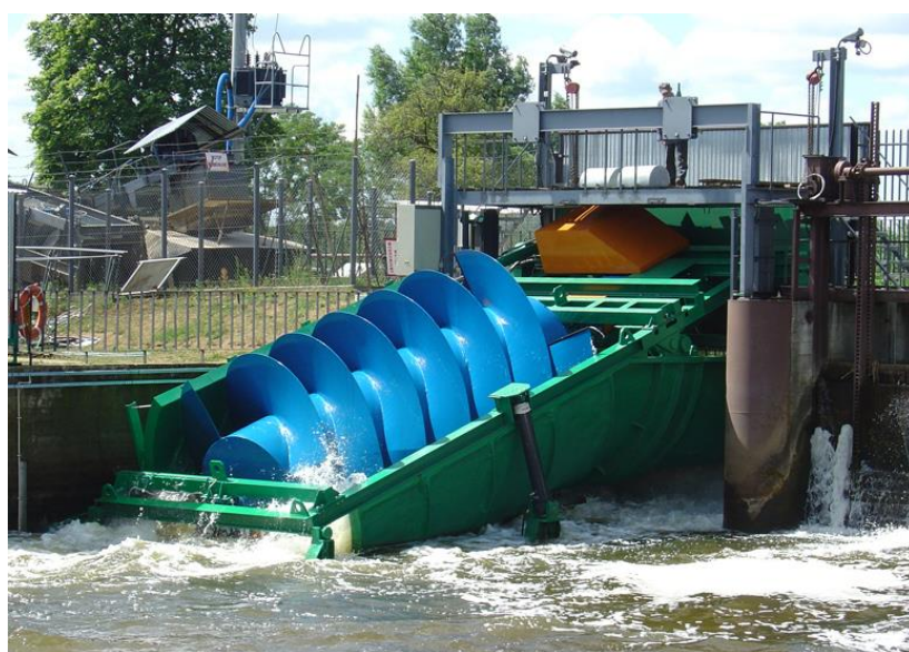
Slika 2.7. Pužna turbina [11]
