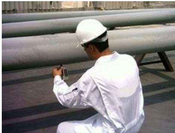
Slika 21. Završna kontrola cijevi
