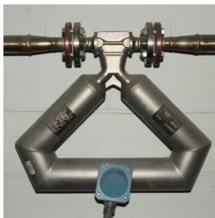
Slika 2.6. Coriolisov protokomjer [2]
