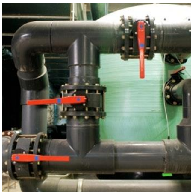
Slika 6. ABS cijevi i prirubnice [4]
