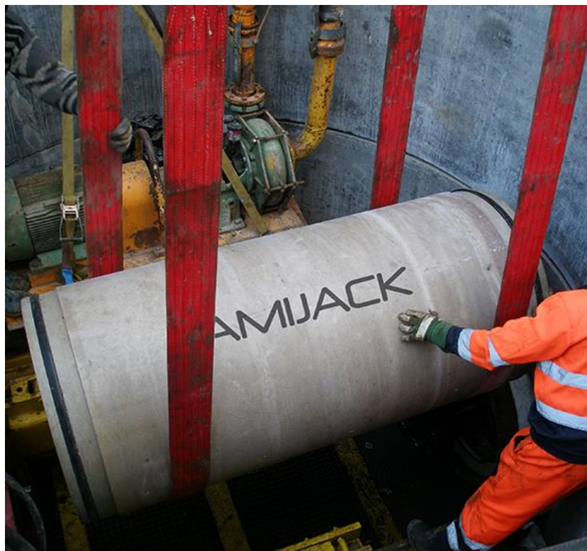
Slika 9. Amijack cijev [9]
