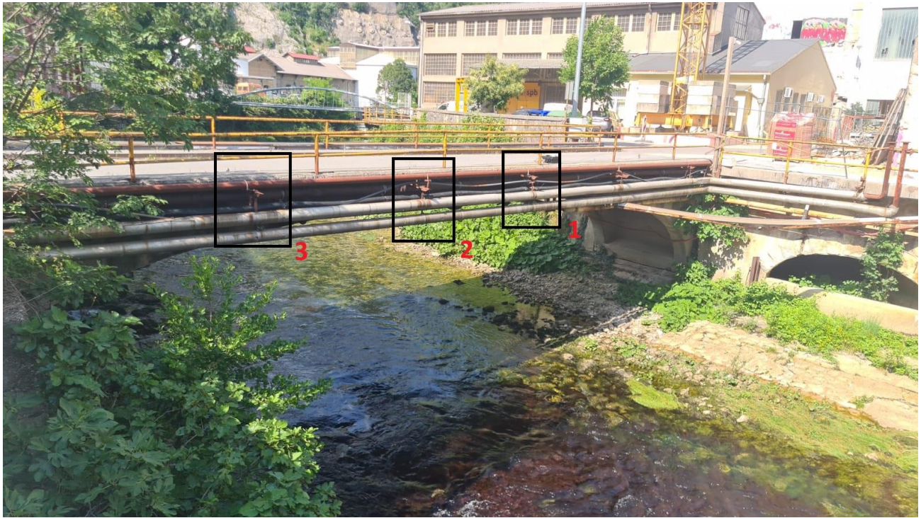
Slika 5.5 Most Marganovo i mjerne točke
