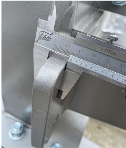
Slika 3.6 Debljina podloge vijčanog spoja nosive konstrukcije platforme
