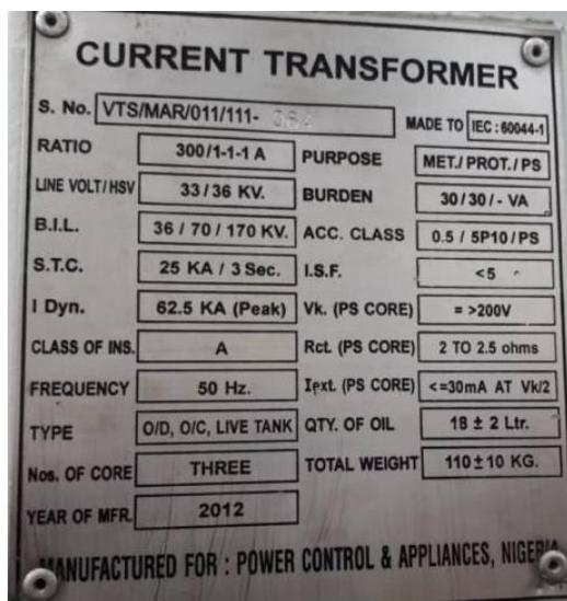
*Slika 4.7. Natpisna pločica strujnog mjernog transformatora [3]*
