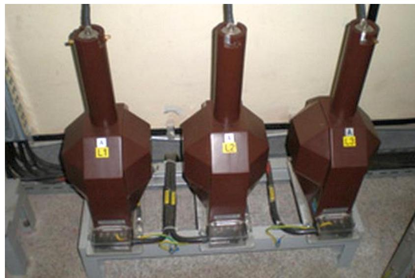
*Slika 3.13. VPA naponski mjerni transformator*
