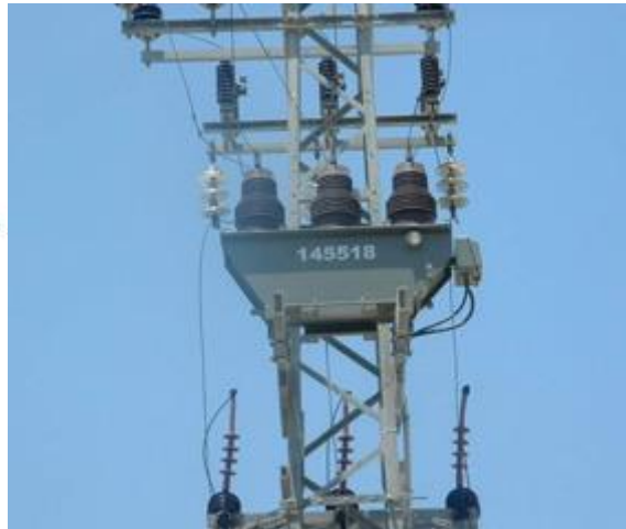
Slika 5.1. Prikaz kombiniranog mjernog transformatora VAH
