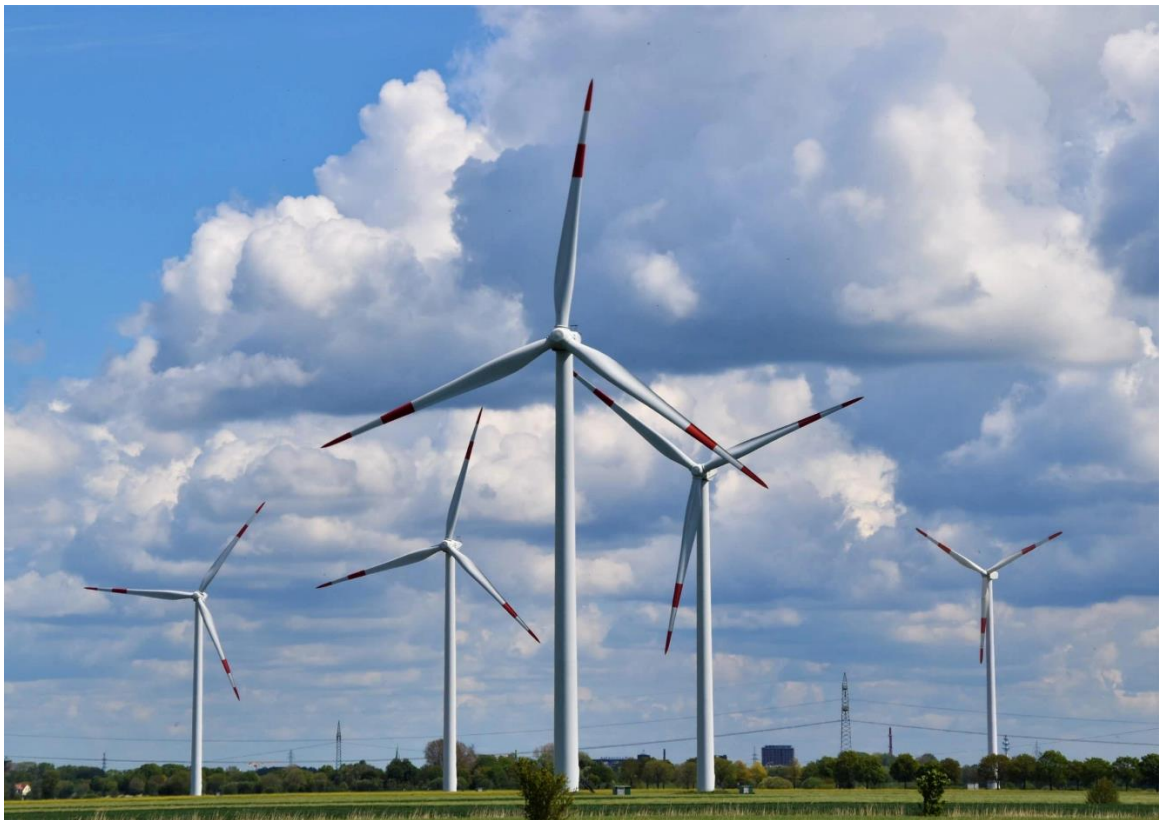
Slika 2.3. Horizontalni tip vjetroturbine
