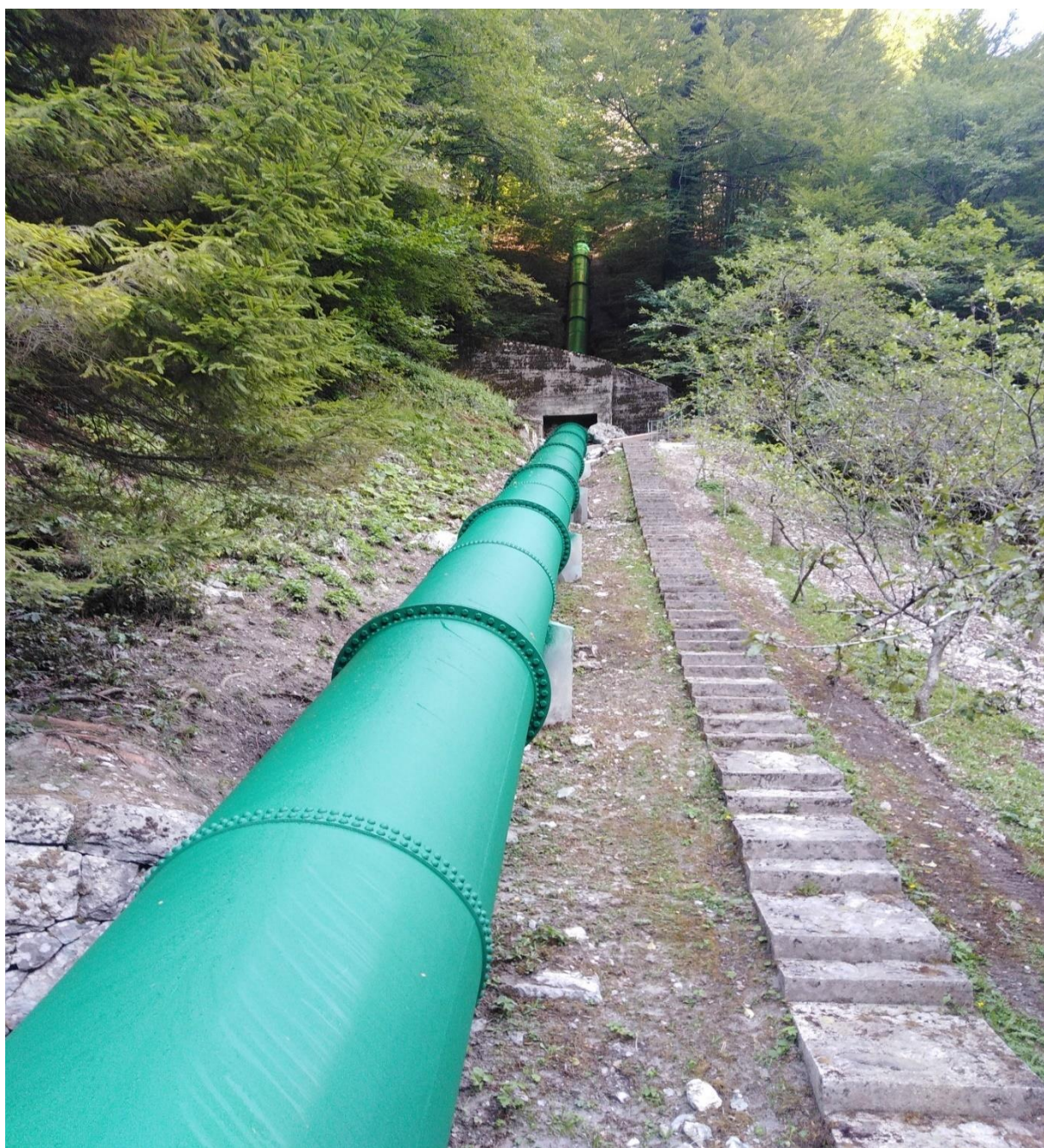
Slika 4.7. Tlačni cjevovod
