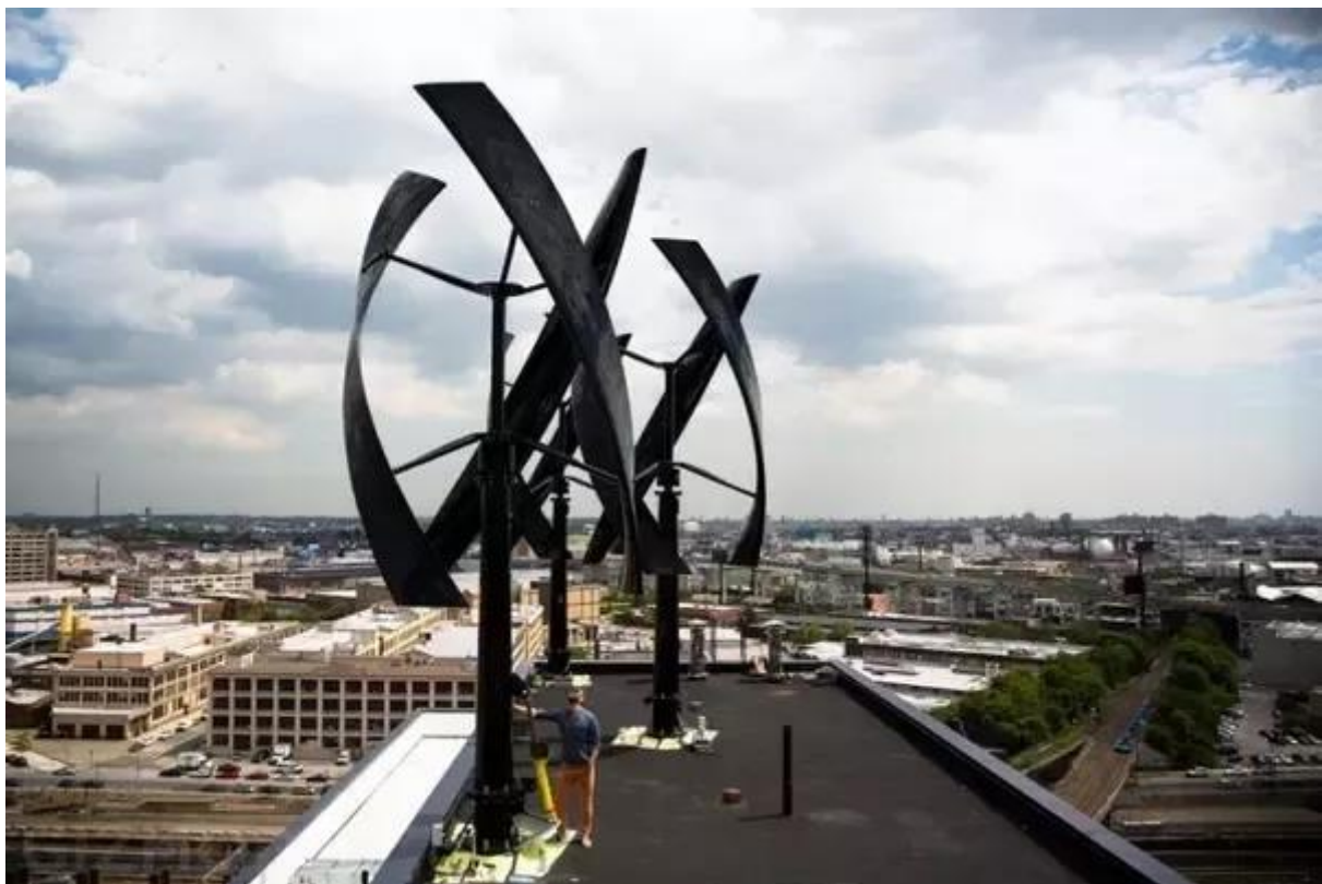
Slika 4.5. Prikaz VAWT krovne vjetroturbine tipa „darrieus“ [30]
