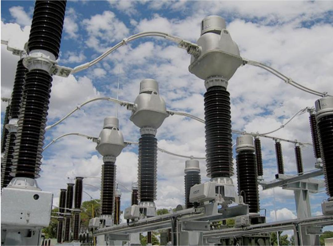
*Slika 2.5. Naponski mjerni transformatori*
