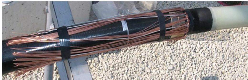
*Slika 6.1: Priprema visokonaponskog kabela za spajanje [2]*
