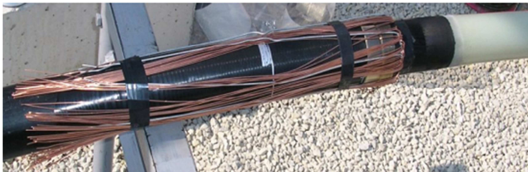
Slika 6.1: Priprema visokonaponskog kabela za spajanje [2]
