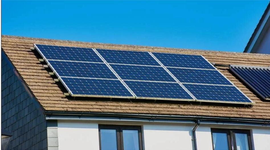
Slika 7 Krovni fotonaponski paneli
