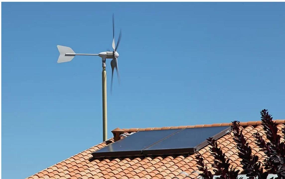
Slika 2 Osobna proizvodnja energije preko solarnih panela i vjetroturbine
