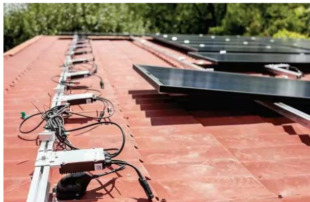
Slika 8.4. Optimizator snage [25]
