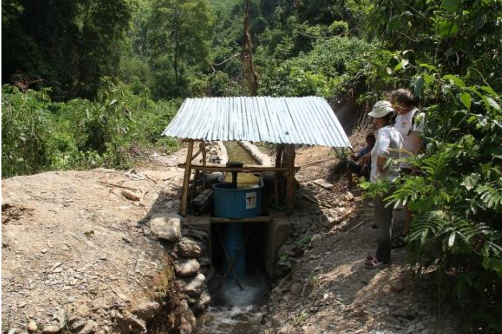
Slika 3.8. HE u ruralnom dijelu Vijetnama sa snagom od 5 kW [17]
