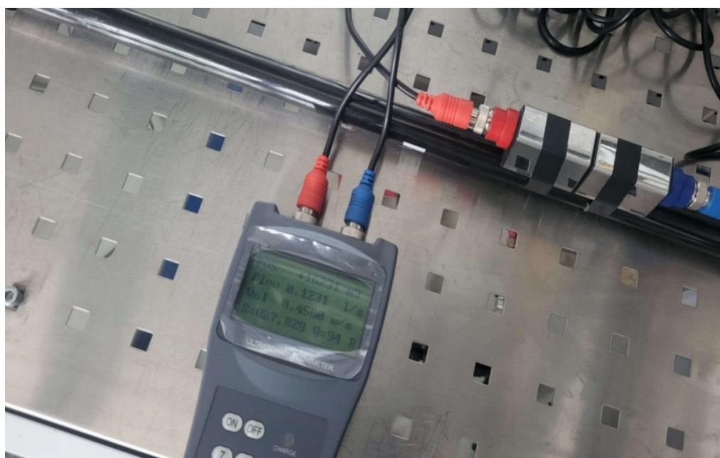
Slika 7.4. Ispravno postavljeni pretvarači na cijev (izvor: autor)
