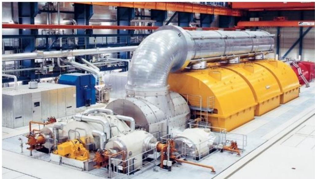
*Slika 2.16. Turbogenerator [3]*
