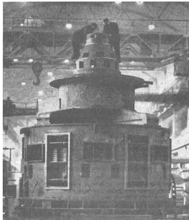
*Slika 2.15. Hidrogenerator postavljen vertikalno s osovinom [4]*
