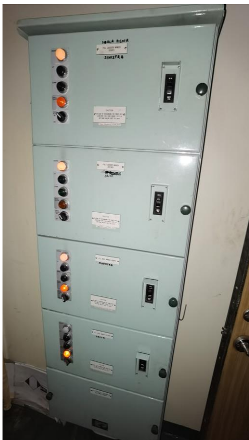
Slika 11.2. Upravljači za vitla (lijevo); Upravljačka jedinica za direktno upravljanje glavnim motorom (desno)
