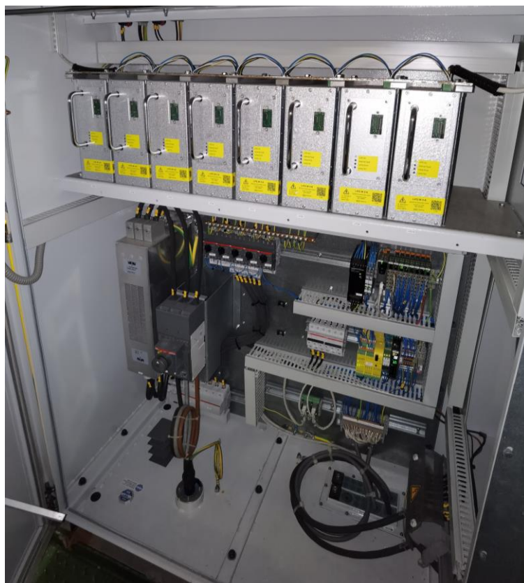
Slika 8.1. Upravljači zajedno s osiguračima i podatkovnim kabelima UV tretmana za balastne vode
