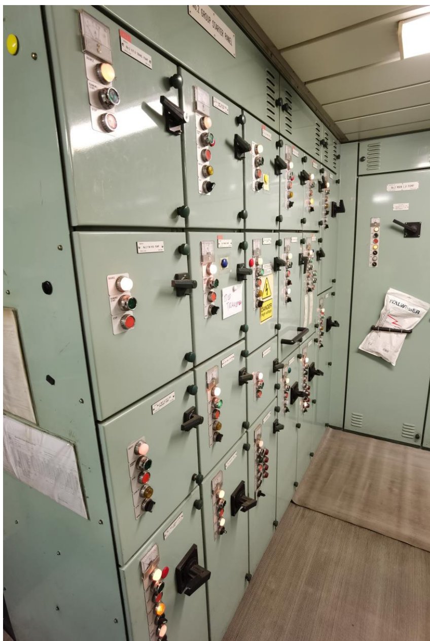
Slika 11.3. Upravljačka centrala za pokretanje uređaja
