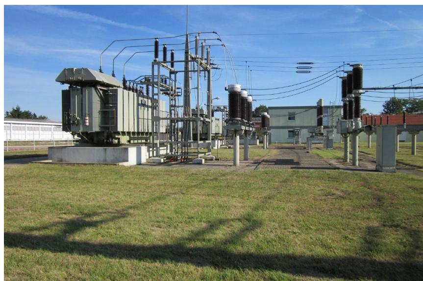
*Slika 2.1. Elektroenergetski transformator*
