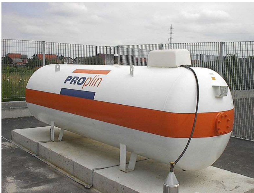
Slika 3.2. Mali nadzemni spremnik UNP-a
