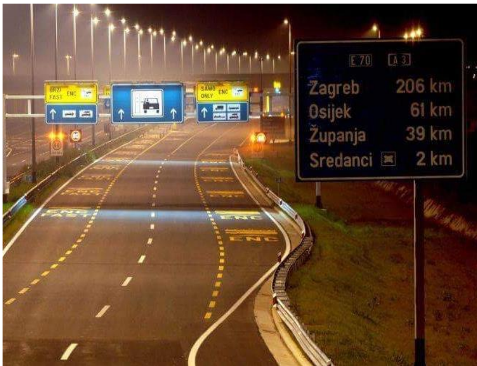
Slika 10. Neadekvatna rasvjeta na autocesti [26]
