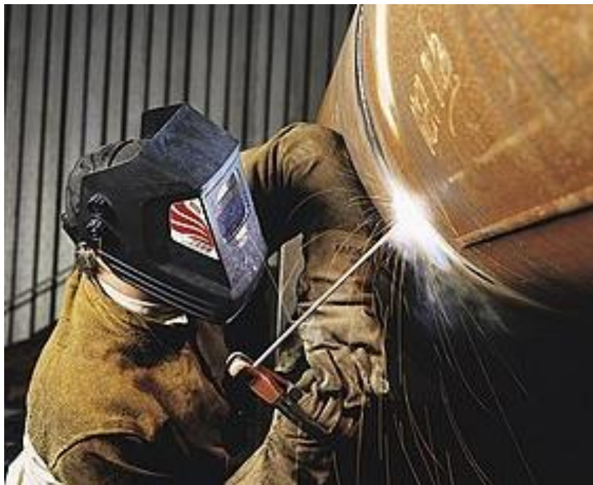
Slika 2 MMA zavarivanje
