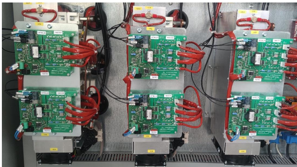
Slika 2.4. Energetski dio izmjenjivača
