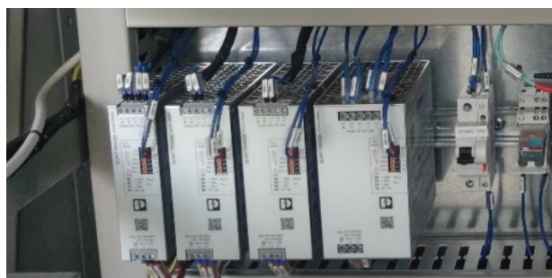
Slika 2.6. Napajanja 24 V
