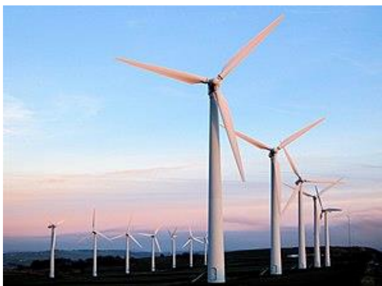
Slika 2.4. Vjetroelektrane Royd Moor u Ujedinjenom Kraljevstvu [5]
