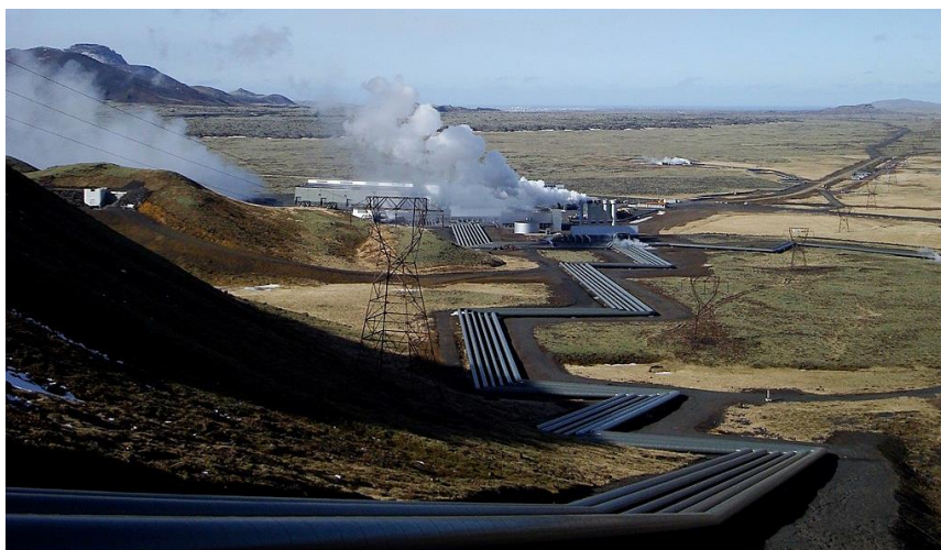
Slika 2.8. Geotermalna elektrana Hellisheiði (Island) [11]
