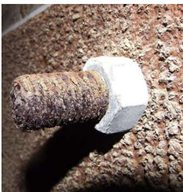
Slika 2.6. Elektrokemijska korozija metala [8]
