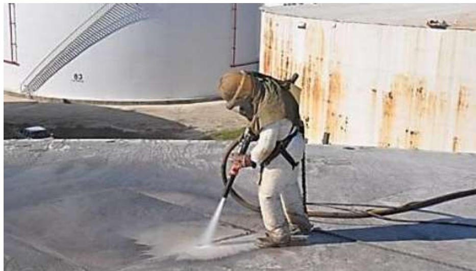
Slika 4.3. Postupak pjeskarenja [13]
